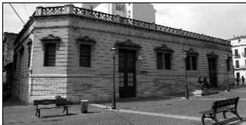
L'edifici de Sa Quartera, un espai en mal estat i desaprofitat.
